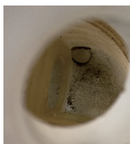
矢印より見たエキスパンションタンク内部底面
