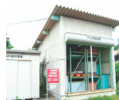
PCB廃棄物保管倉庫
