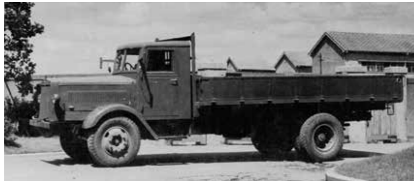
1946年1月に戦後初めて完成したTT9型トラック。1939年完成の小型で強力なND2型エンジンを搭載した。輸送力増大を最重要課題に置いていた当時の日本において、好評を博し、日本各地から注文が届いた。
